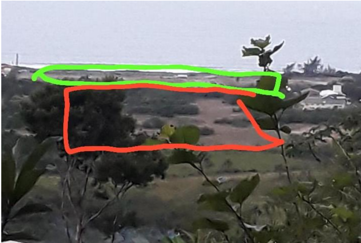
Figura 3: Vista geral da área do empreendimento no dia 18 de junho de 2021. A porção destacada em verde é a área já atingida pelas obras. A porção destacada em vermelho ainda não foi impactada. Fonte: Fotografia feita por morador(a) local.
